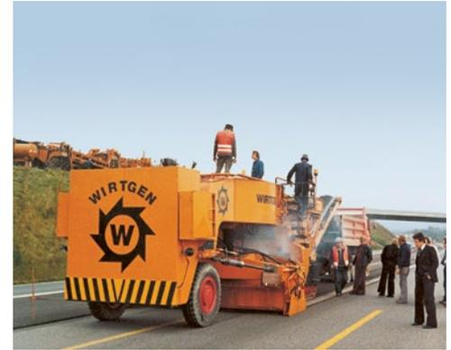
Fräse zum Ausbrechen von Asphalt, 1979
