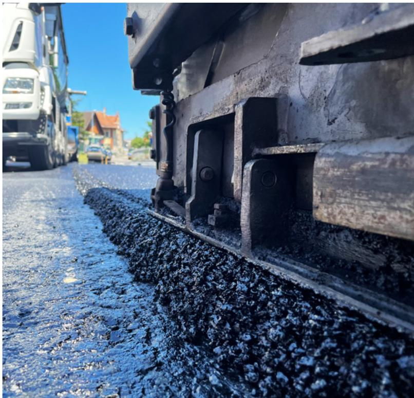
**Offensive für einen nachhaltigeren Strassenbau: Der Belag des Velo- und Gehwegs besteht aus bis zu 90 Prozent Recyclingasphalt.**
