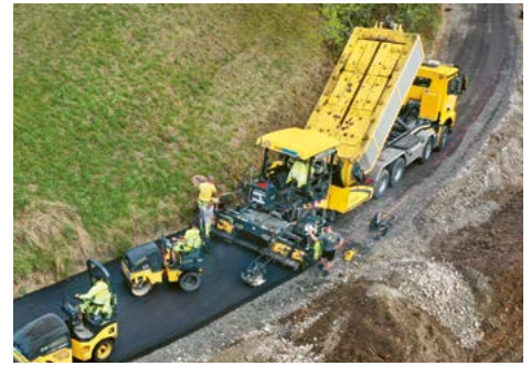
Urs Schatt Tiefbau GmbH > www.urs-schatt.ch
